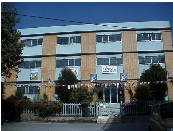
Εικόνα 1: Βιομηχανία μεταποίησης παιδικών ρούχων ALLEGRO A.E. (Μεταμόρφωση, Αττική) – Διαθέτει 50 τ.μ. ηλιακών συλλεκτών
