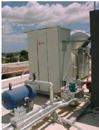
Σχήμα 2. Αριστερά η αντλία θερμότητας αέρα και δεξιά το κιβώτιο μείξης, με προσαγωγή ηλιακού αέρα στον εξατμιστή και προστασία έναντι υπερθέρμανσης (μελέτη Bonair)
