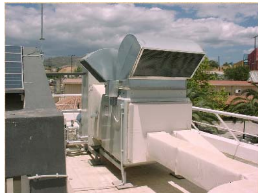
Σχήμα 2. Αριστερά η αντλία θερμότητας αέρα και δεξιά το κιβώτιο μείξης, με προσαγωγή ηλιακού αέρα στον εξατμιστή και προστασία έναντι υπερθέρμανσης (μελέτη Bonair)
