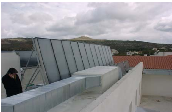
Εγκατάσταση 50 m 2 ηλιακών συλλεκτών αέρα στην οροφή του Ευρωπαϊκού Κέντρου Δημοσίου δικαίου και προσαγωγή στην κεντρική κλιματιστική μονάδα (έργο Bonair)
