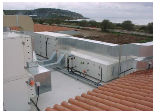
Εγκατάσταση 50 m 2 ηλιακών συλλεκτών αέρα στην οροφή του Ευρωπαϊκού Κέντρου Δημοσίου δικαίου και προσαγωγή στην κεντρική κλιματιστική μονάδα (έργο Bonair)
