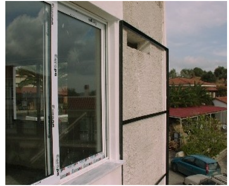
Ηλιακοί συλλέκτες αέρος 21 m 2 στη νότια πρόσοψη του κτιρίου γραφείων του Κέντρου Ανανεώσιμων Πηγών Ενέργειας (ΚΑΠΕ) στο Πικέρμι (μελέτη Bonair)
