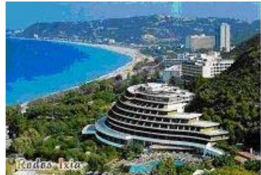
Νέο έργο ηλιακού κλιματισμού 350 kW στο ξενοδοχείο Olympic Royal στη Ρόδο. (μελέτη Bonair)
