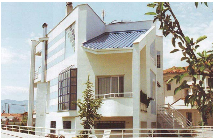
Ηλιακή κατοικία στην Πεύκη με 32 m 2 συλλεκτών για θέρμανση νερού και χώρων
