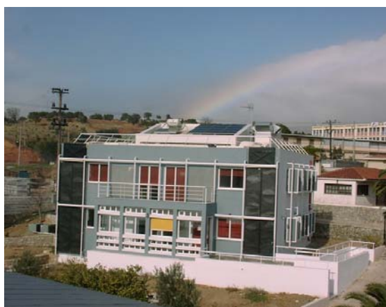
Εικόνα 1: Το βιοκλιματικό κτίριο του ΚΑΠΕ στο Πικέρμι Αττικής με τους ηλιακούς συλλέκτες αέρα συναρμολογημένους αριστερά και δεξιά σε δύο συστοιχίες
