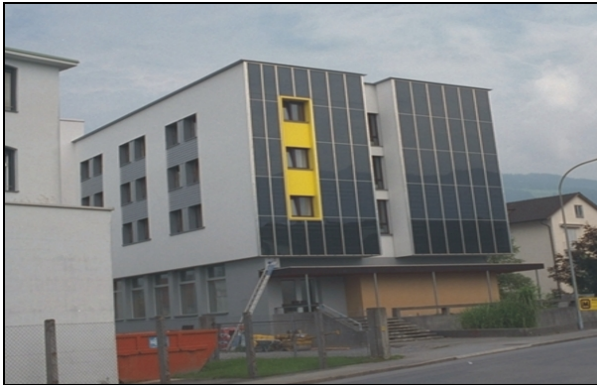
Εικ. 9: Συλλέκτες τοποθετημένοι στη (νότια) όψη κτιρίου στην Αυστρία (πηγή: DOMA)
