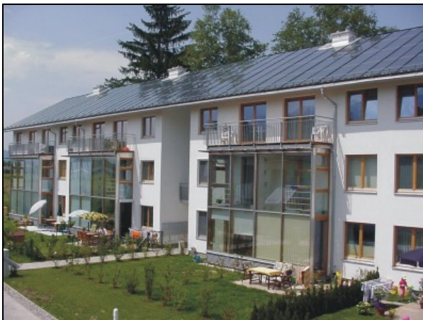
Εικ.3. Ηλιακή στέγη σε Αυστριακό σύστημα combi (πηγή: GSWB)
