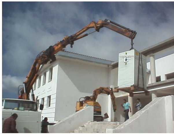
Εικ. 1.β Άποψη του ξενώνα κατά την κατασκευή του γεωθερμικού συστήματος
