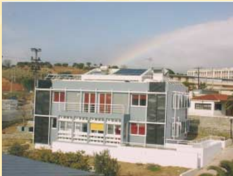
Ηλιακοί συλλέκτες αέρος στη νότια πρόσοψη του κτιρίου γραφείων του Κέντρου Ανανεώσιμων Πηγών Ενέργειας (ΚΑΠΕ) στο Πικέρμι
